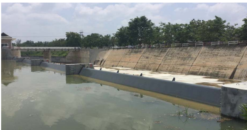
รูป ๘ ฝายหลักพับได้ Type III-A บนสันของ Spill Way ของอ่างเก็บน้ำประแสร์ อำเภอวังจันทร์ จังหวัดระยอง
