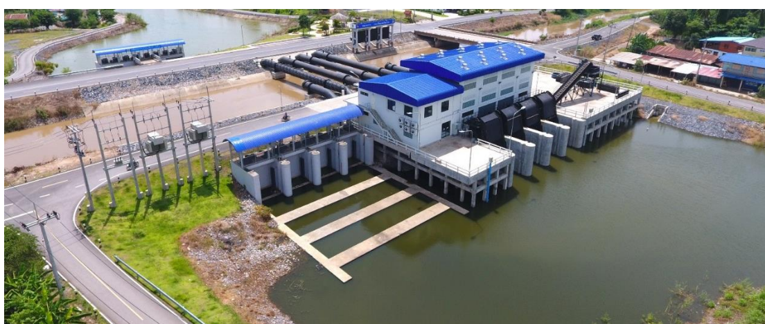
ภาพที่ ๓.๓ แสดงสถานีสูบน้ำปลายคลองระบายใหญ่ชัยนาท-ป่าสัก ๒ (บางโฉมศรี) เมื่อแล้วเสร็จ
