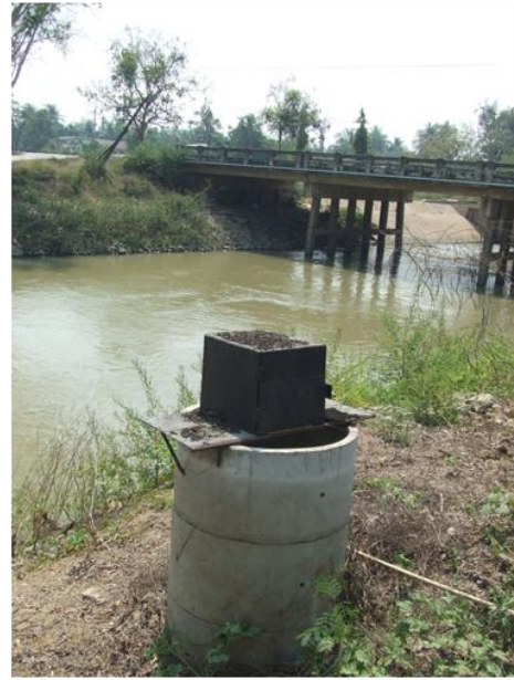
(ข) บ่อน้ำนิ่งด้านท้ายอาคาร
